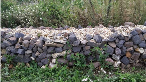
Einfache Trockenmauer
